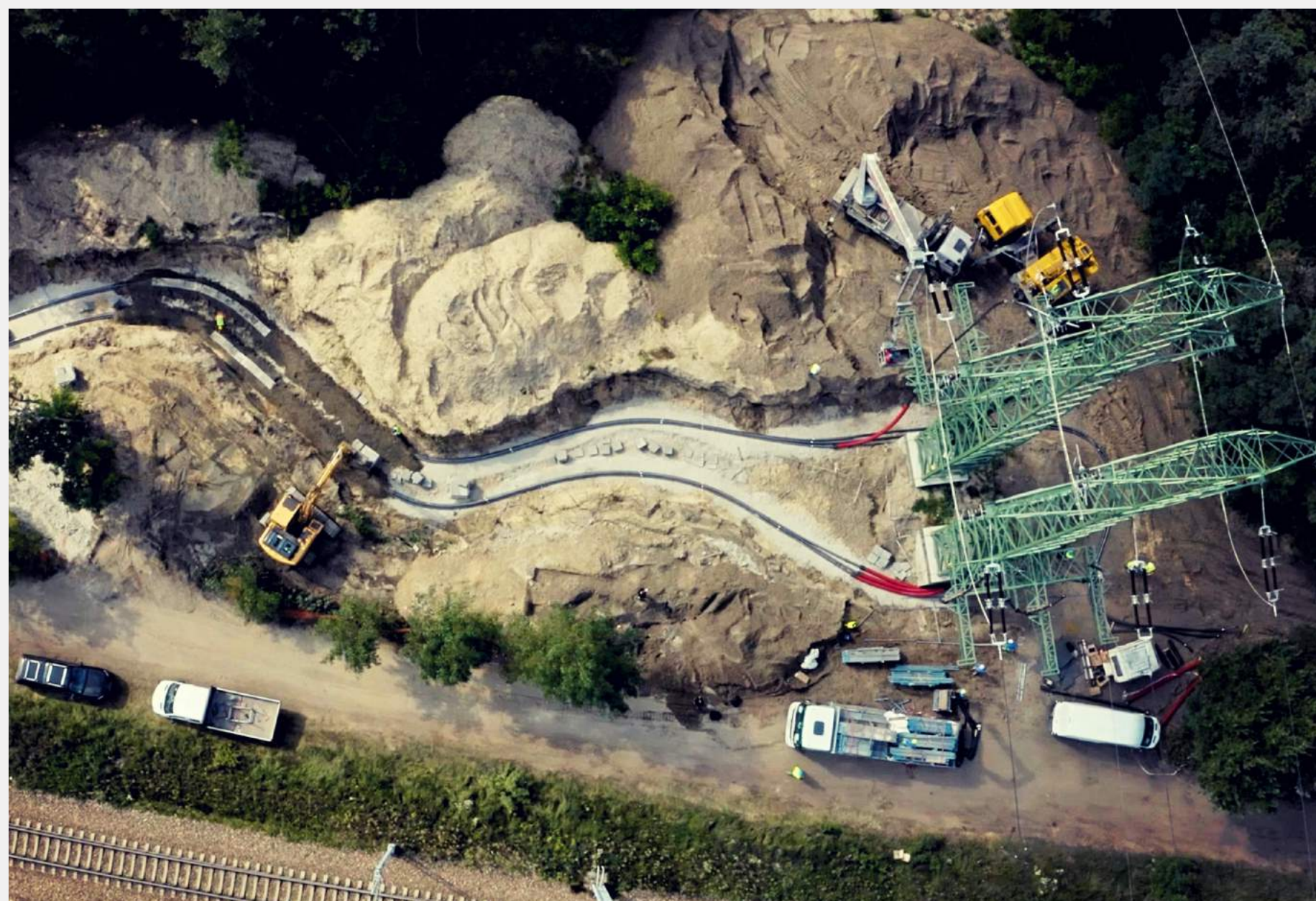
Miejsce przyłączenia linii kablowych do linii napowietrznej Miłosna - Mory
