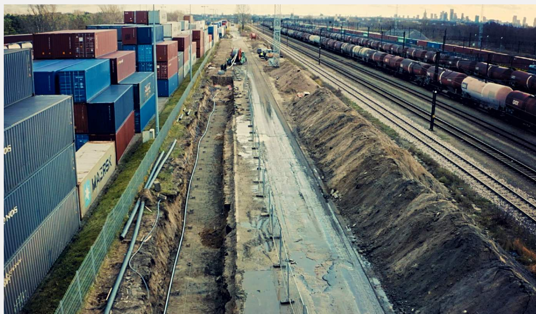
Układanie linii w wykopie otwartym na terenach kolejowych
